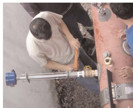
VMI sendo instalado na adutora da Sabesp no Alto da Boa Vista/SP
